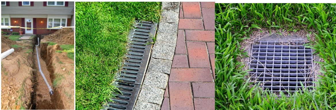
Infraestructuras de jardines: pavimento, desagüe.
